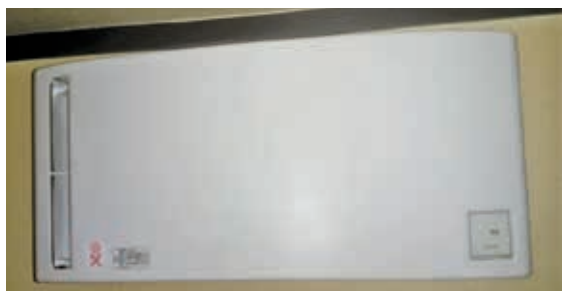
換気による室内の温度変化を抑える全熱交換機
