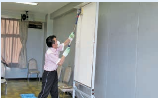
壁面洗浄作業
